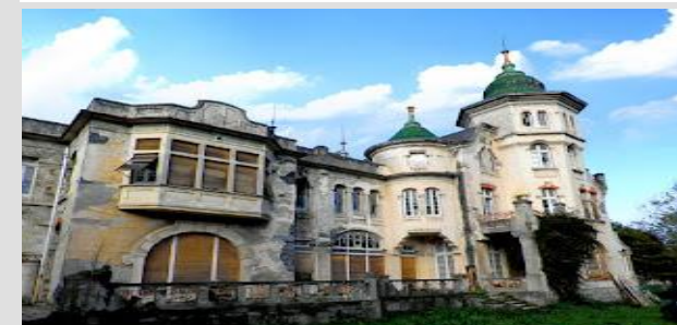
Villa Excelsior (Barcellona, Asturias)
