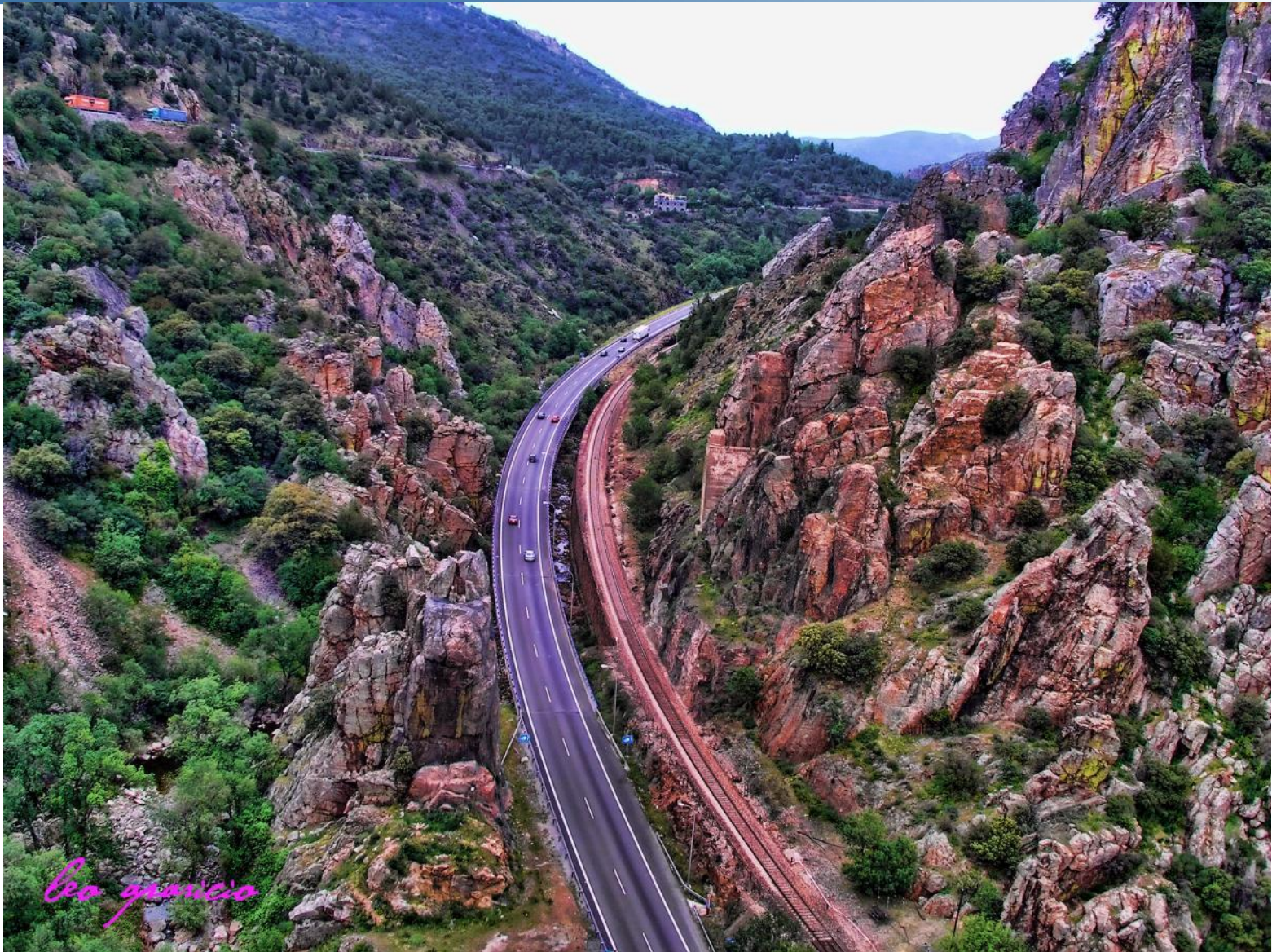
Paso de Despeñaperros
