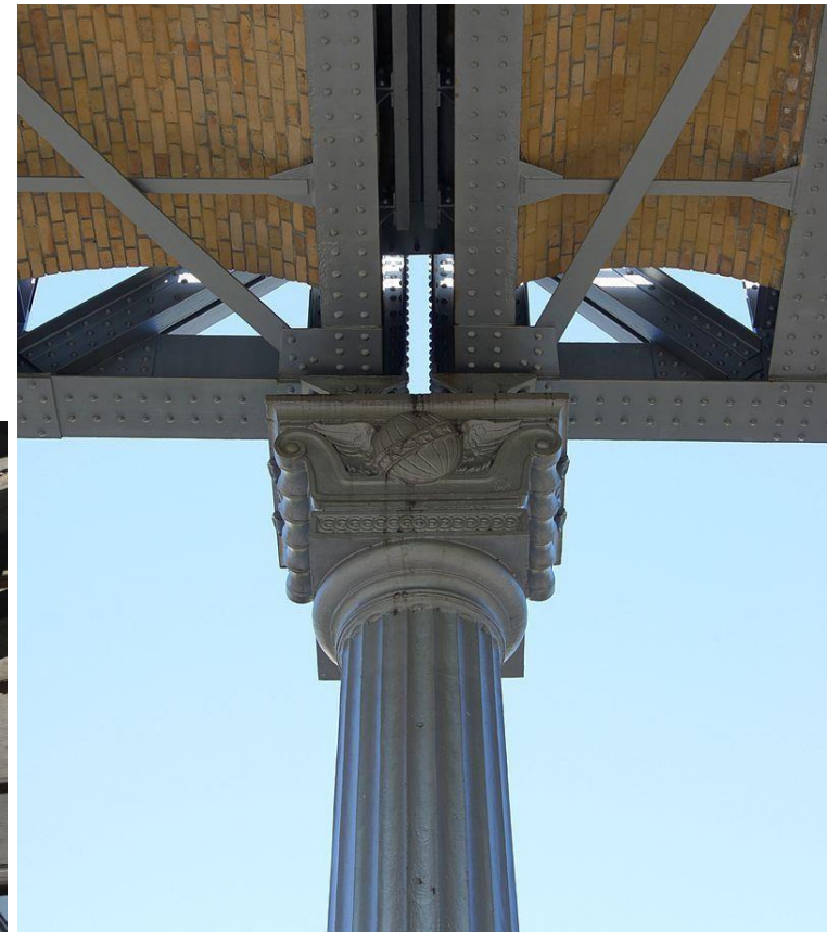
Detalle de una marquesina del Metro de París.
