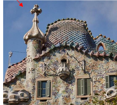
Tejado recubierto con cerámica vidriada.
