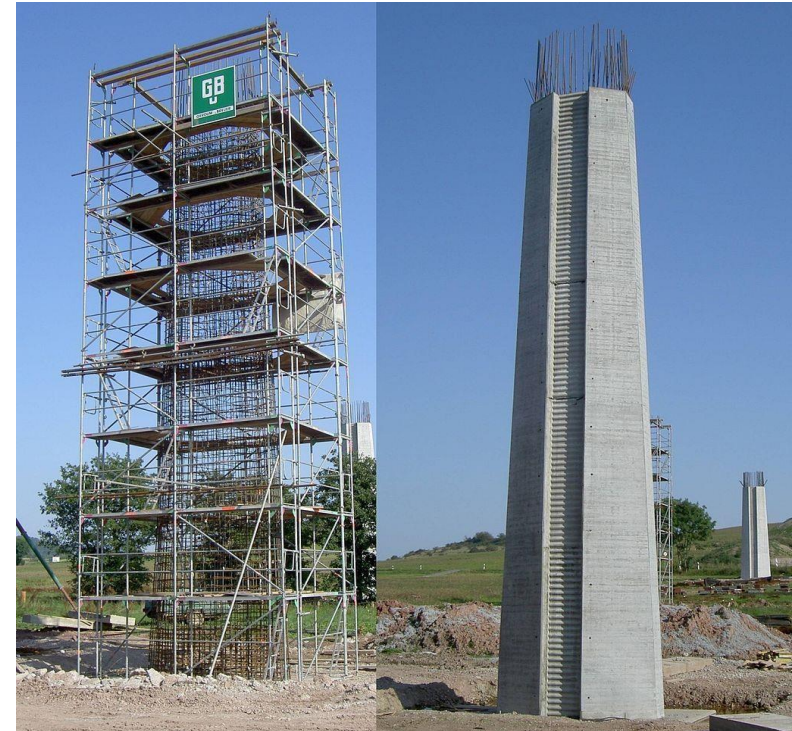
Pilar de un puente de hormigón armado.
