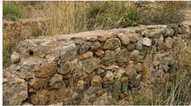
MUROS DE MAMPOSTERÍA
