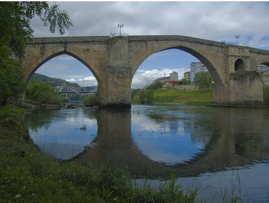
Puente de Orense
