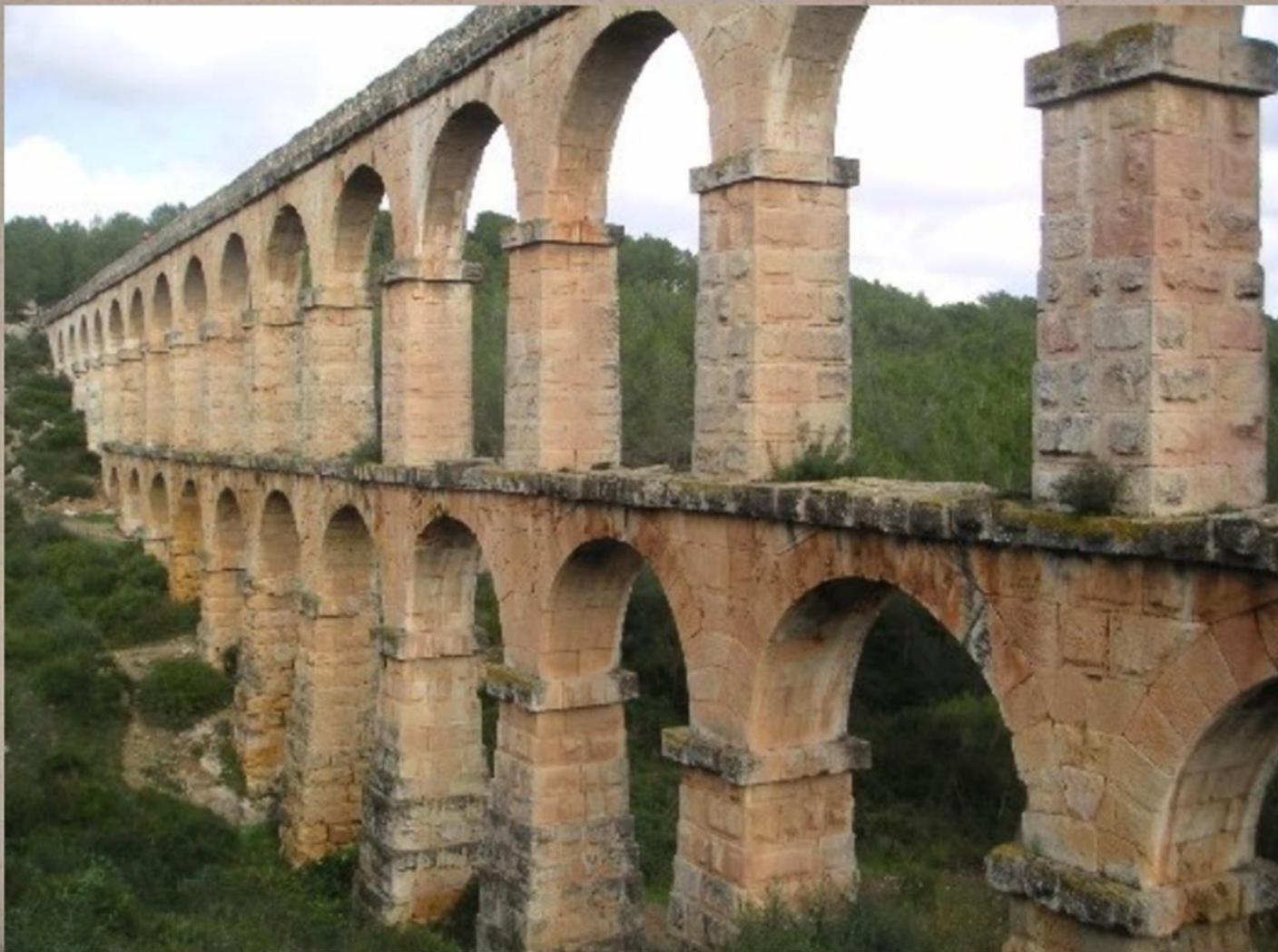
Acueducto de Ferreras (Tarragona- s.II)
