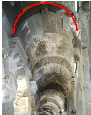
Bóveda de cañón
