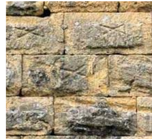
MUROS DE SILLERÍA
