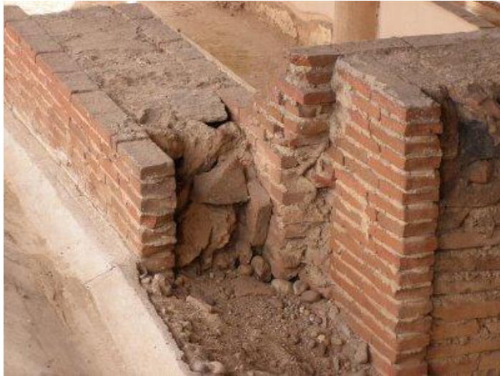
MUROS DE LADRILLO DOBLES Y REFORZADOS
