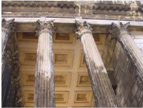
Techumbre interior con retícula de casetones.
