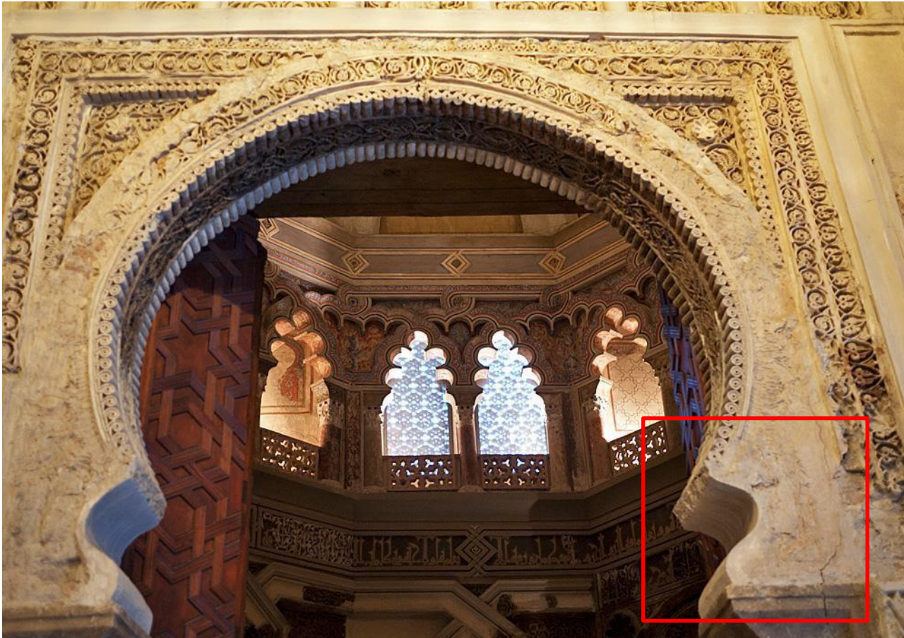
Oratorio. Detalle del arco de acceso. En rojo, los salmeres (dovela basal) serpentiformes.
