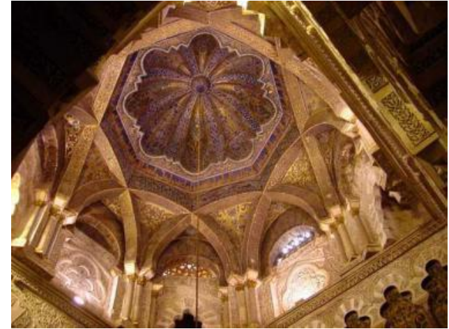
Cubierta cupulada con arcos cruzados y cúpula gallonada.
