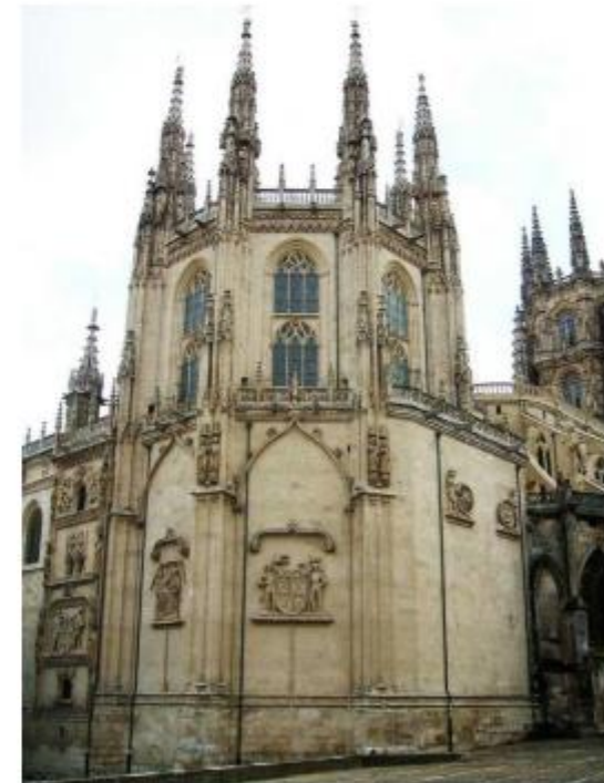
Exterior de la Capilla del Condestable . Burgos.
