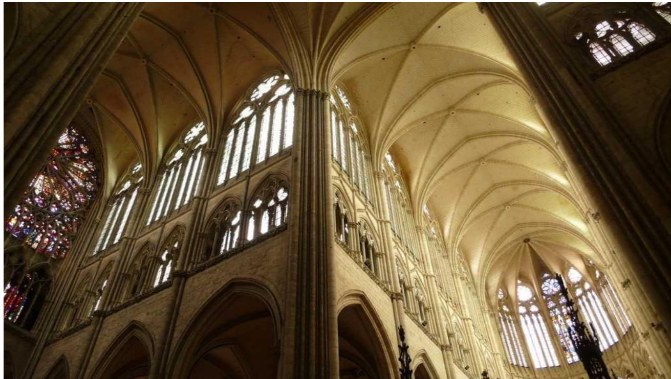
Catedral de Amiens. Interior. Transepto y nave central en la cabecera. Triforio calado
