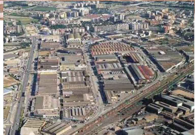
Polígono de Malpica, Zaragoza
