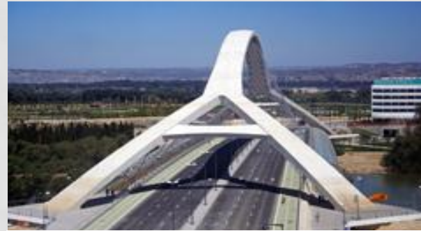
Puente del Tercer Milenio (España), de Juan José Arenas y Asociados
