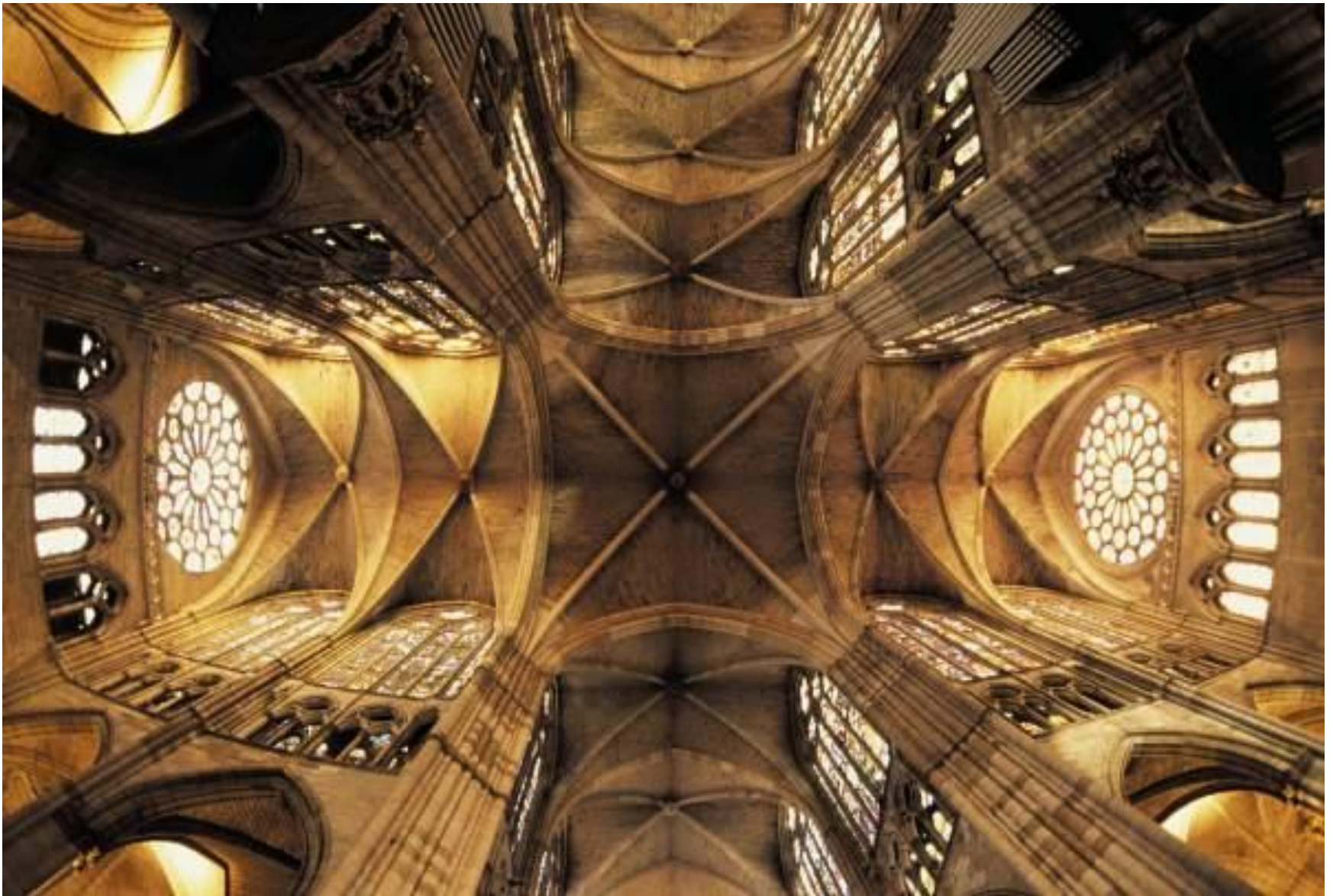
Bóvedas de crucería en el crucero de la catedral de León (siglo XIII).
