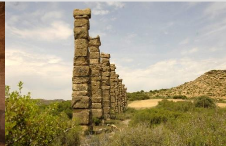
Pilares del acueducto de los Bañales
